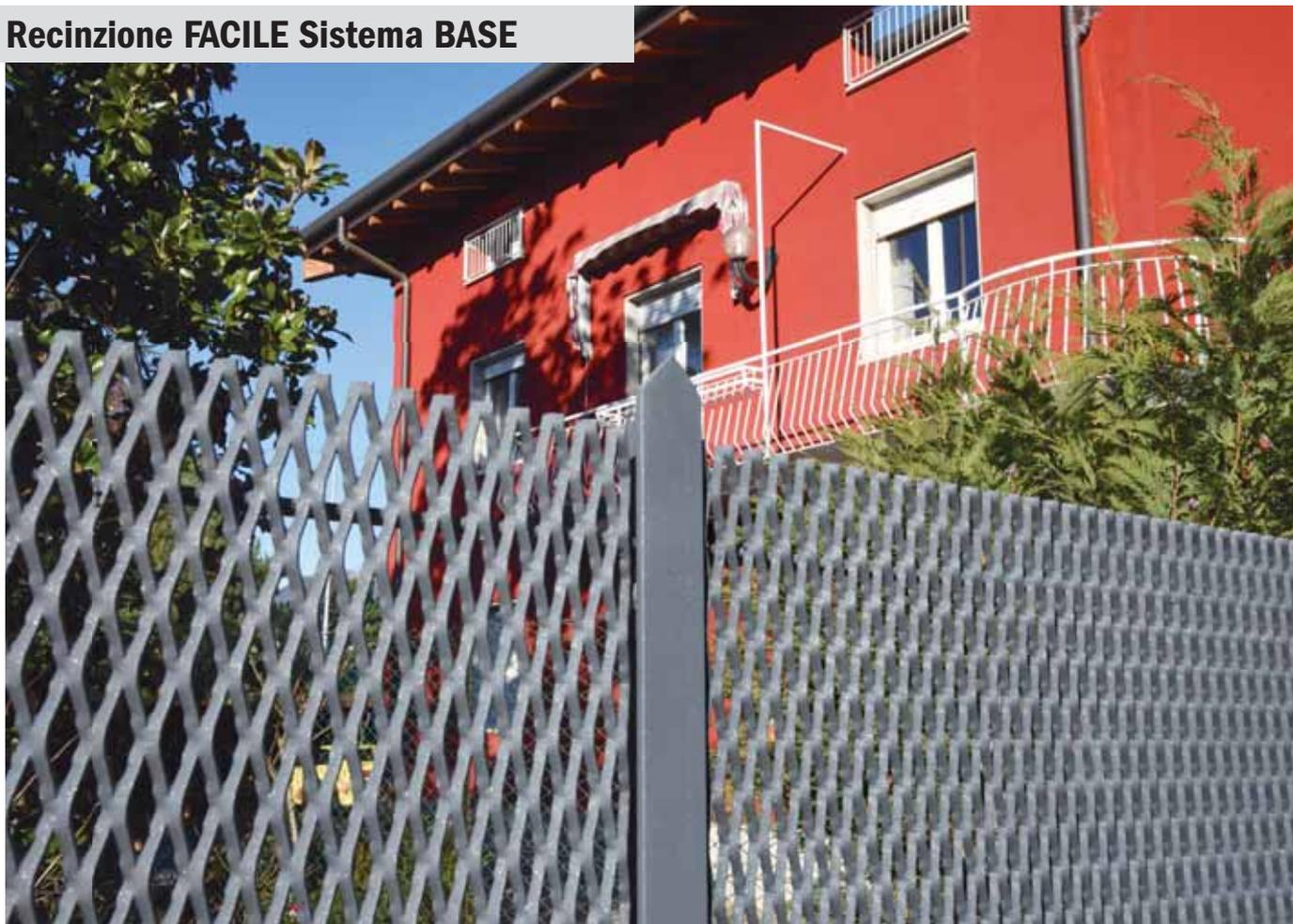
La recinzione FACILE Sistema BASE impiega una particolare maglia "dentata" e disposta in verticale. La rete stirata è saldata a un profilo longitudinale in ferro che forma una recinzione continua, senza spazio tra un pannello e l'altro.
